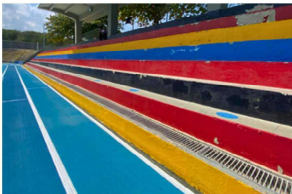
Adecuación y pintura de la gradería de la pista atlética (culminado).
