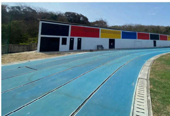
Adecuación y reparación de la pista atlética (culminado).
