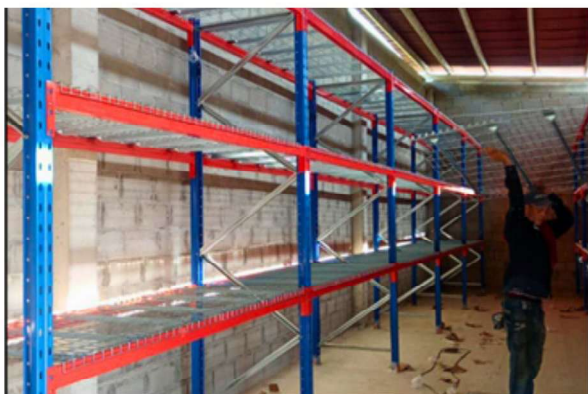
Adecuación de bodega con estantería metálica (culminado).
